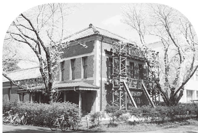
旧第五高等学校化学実験場復旧工事(平成30年3月24日撮影)
