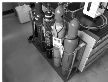
床に確実に固定し、二重に鎖で転倒防止策を行った高圧ガスボンベ
