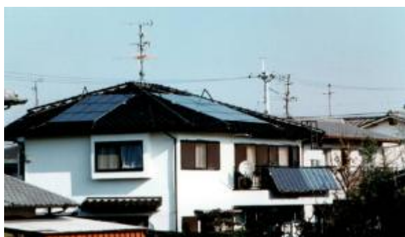
図 8. 最初の実生活逆潮流有り太陽光発電システム（桑野太陽光発電所）
